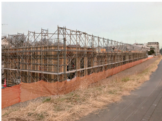
スマイル工房新築工事の様子。
